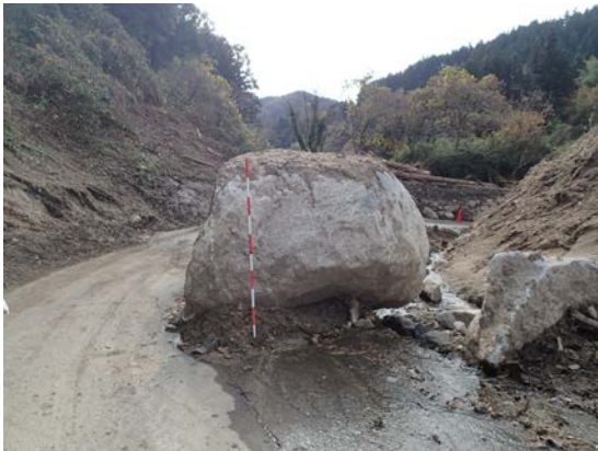
(町道まで流出したコアストーンと土砂)
