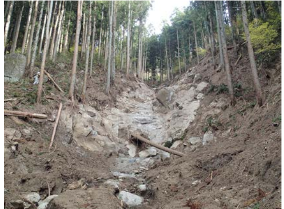
(崩壊源頭部付近)
