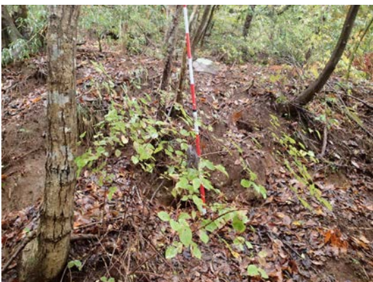
(斜面上部の段差)
